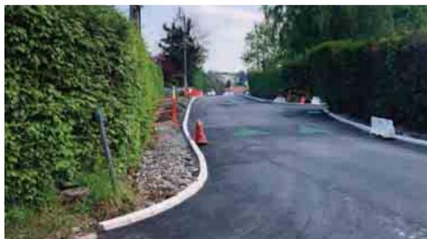
**Attention si vous circulez sur ce tronçon, les bouches d'égout, les grilles d'eaux pluviales, clefs d'eau potable ont été mises au niveau définitif et dépassent de la couche d'enrobé en place.**
